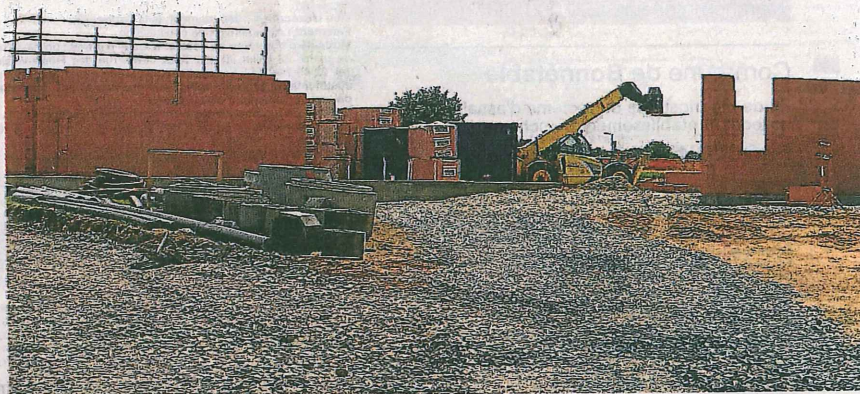
Les travaux du dojo, salle d'arts martiaux, viennent de commencer près du stade Rémy-Lambert. L'ouverture de la structure est prévue à la rentrée 2015.
